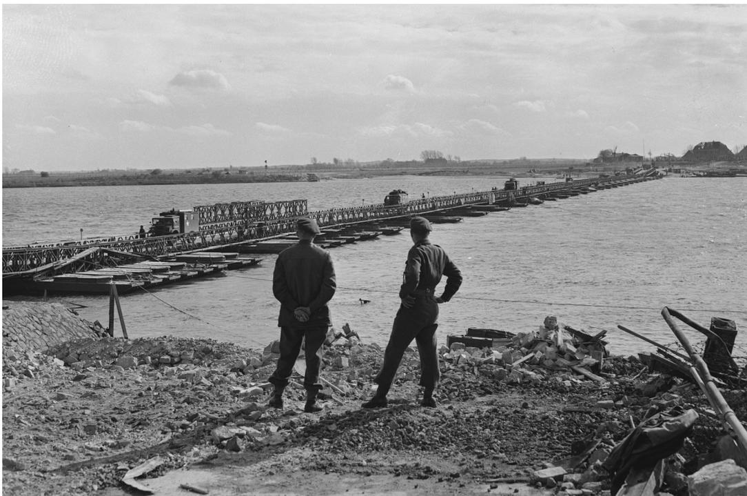
Abb. 9. Und 10.: Fahrzeuge überqueren die durch kanadische Pioniere errichtete 15t-„Contractors-Bridge“ über den Rhein.
