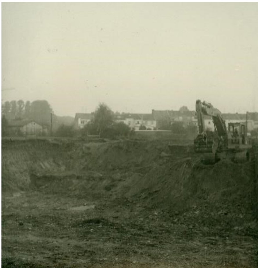
Abb. 2.: Erste Erdarbeiten auf dem Gelände.
