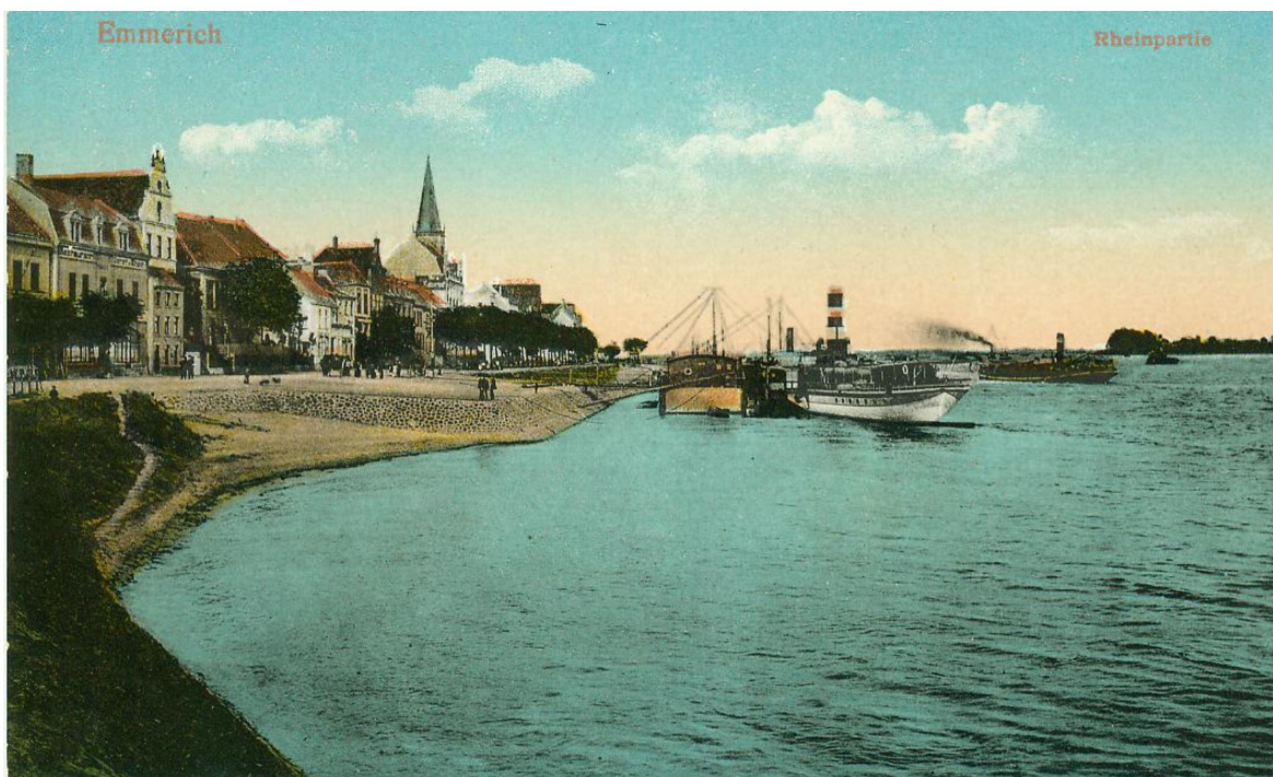
Abb.1.: Anlegestelle „Stadt Emmerich“ ca. 1920.
