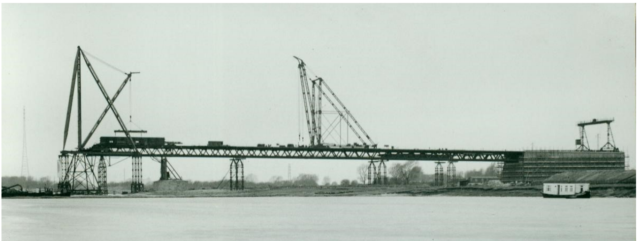
Abb.5.: Die Emmericher Rheinbrücke im Bau 1964.
