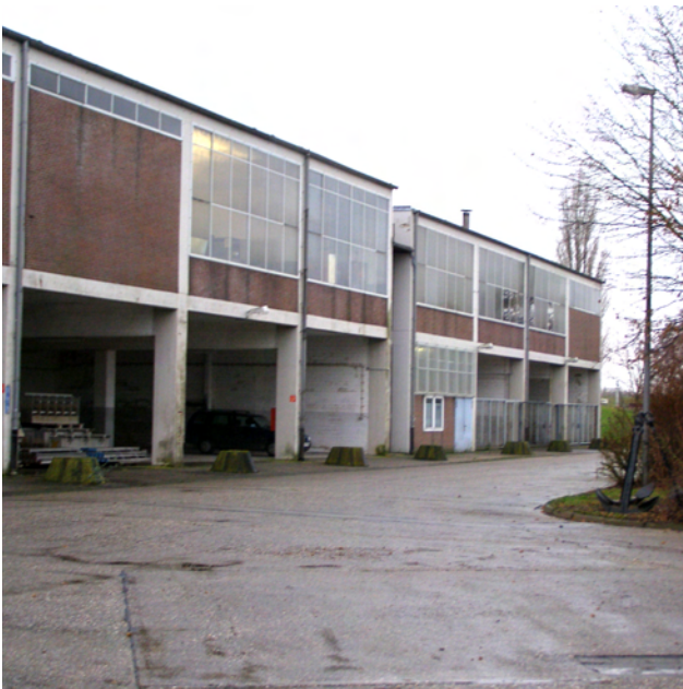
Großes Lager- und Werkstattgebäude (Nordseite)
