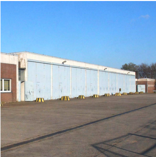
Großes Lager- und Werkstattgebäude (Südseite)
