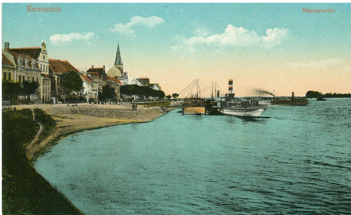
Abb. 1.: Anlegestelle „Stadt Emmerich“ ca. 1920.
