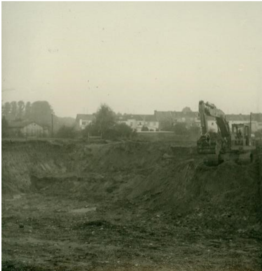
Abb. 2.: Erste Erdarbeiten auf dem Gelände.
